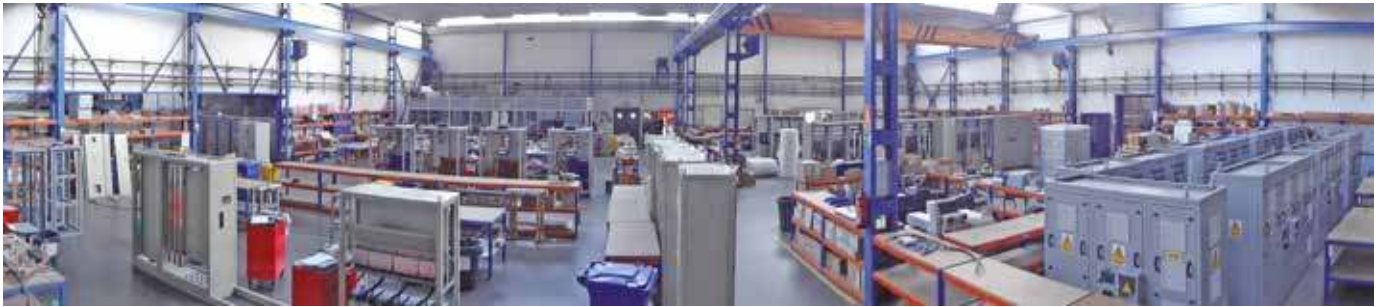
Panorámica de la fábrica de cuadros eléctricos y de electrónica de potencia.
