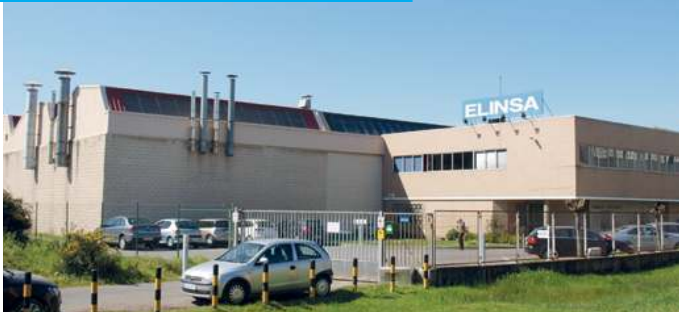
Oficinas centrales de Elinsa en A Coruña
