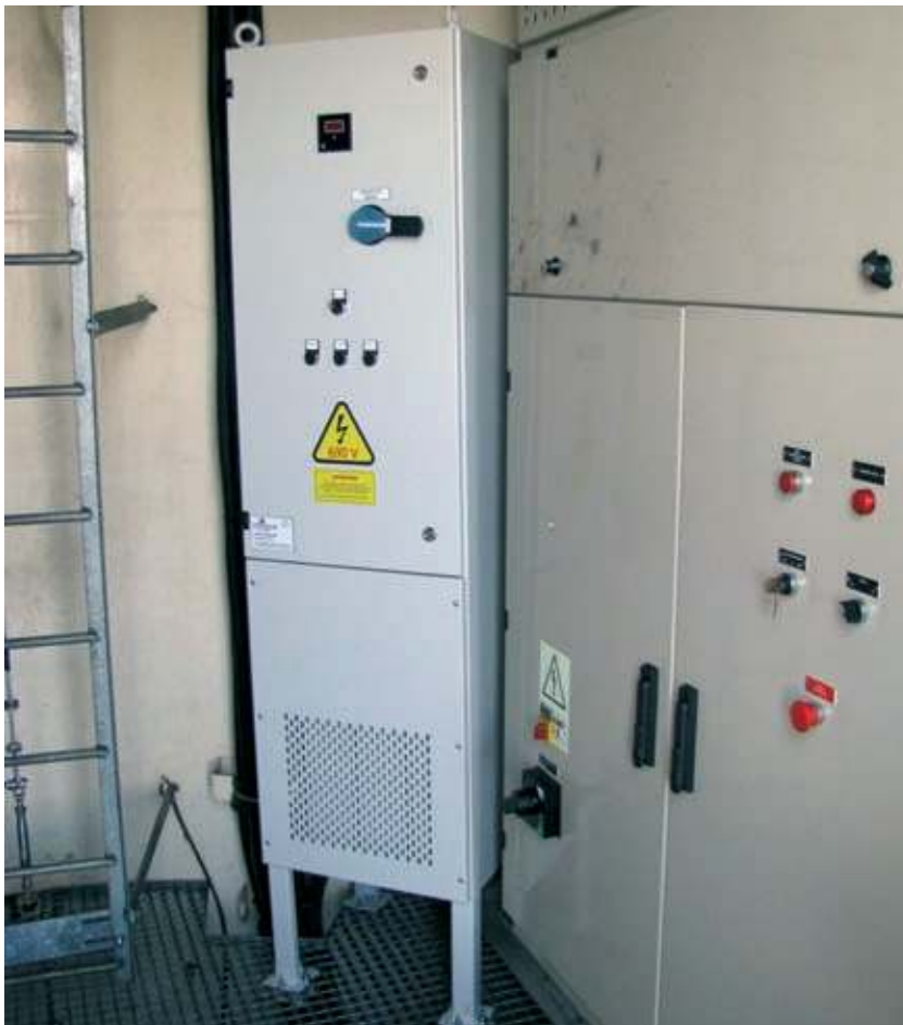
Fase de instalación
